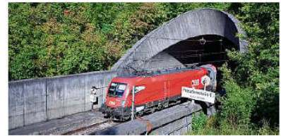
Nicht nur Schnellzüge verkehren auf der Strecke. Im Vergleich zum ICE bringt es der Interregio am Ostportal bei Zaisersweiher auf wesentlich weniger Stundenkilometer.
